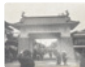
開府300年祭 「長岡停車場装飾門」
